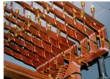
サンプリング盤 (銅管6Φ群)
