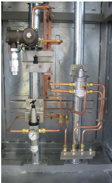
電磁弁・減圧弁収納盤 空気配管チューピング (銅管6.8Φ)
