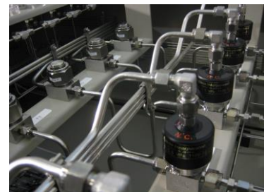
サンプリング盤(SUSチューブ6.8Φ)
